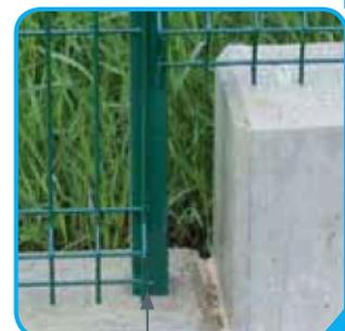
H+S empfiehlt eine Lüftungsbohrung nach der Montage wegen Kondenswasserbildung.
